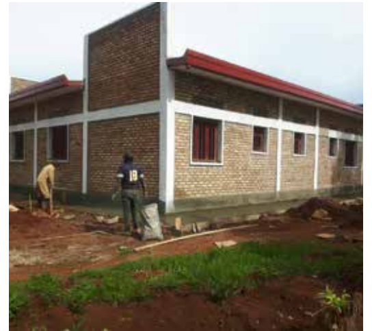
Im April steht bereits der Rohbau des zukünftigen Therapiezentrums. Fotos: Afrika-Hilfe-Stiftung
